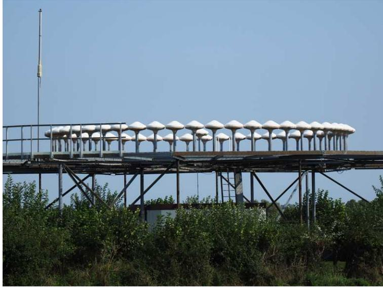
Abbildung 5.12.: Zirkulare Gruppenantenne eines Drehfunkfeuers
